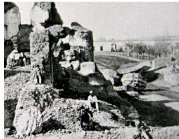
7/8/9. Ruinas de la Antigua Ciudad de Mendoza, destruidas por el terremoto del 20 de marzo de 1861, 1880 c. (Fotografías y detalles) / Fuente: AHM
