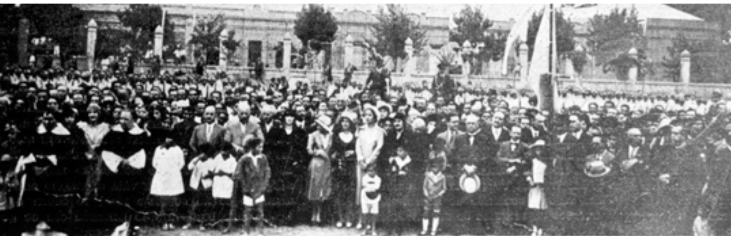
21. Colocación de la piedra fundamental. (Fotografía) / Fuente: ibidem
