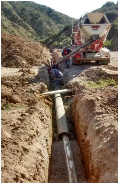
Imagen 15: hormigonado de caño camisa
