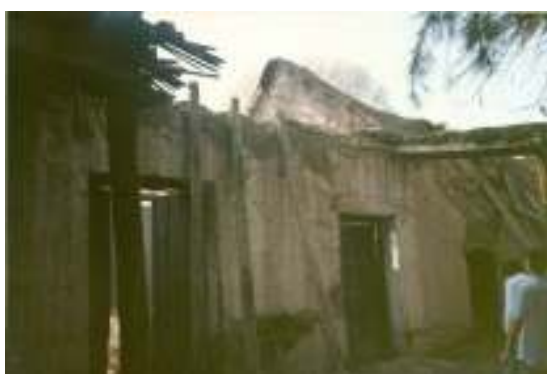
Fig. 18.- Techo con pendiente llamado “lomo de buey”
