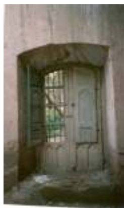
Fig. 75. Ventanas con rejas de hierro
