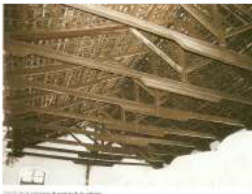
Fig. 41.- Bodegas González Videla – Panquehua – Las Heras Cuerpos 1856-1859 – Tijerales de álamo
