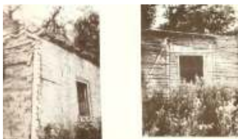
Fig. 68 y 69.- Construcción de quincha
