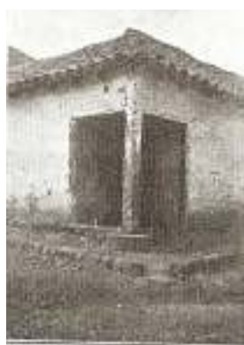
185.-Pilar de ángulo.—Petorca, Chile.—Ejemplo modesto de una solución arquitectónica interesante.
