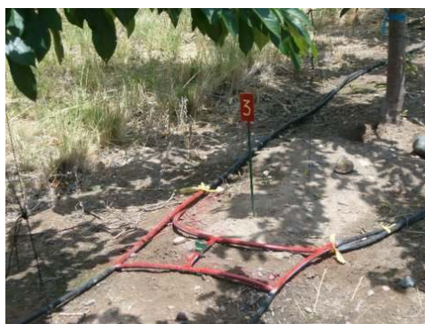
Foto1: Detalle del sistema de derivación instalado para el riego del ensayo
