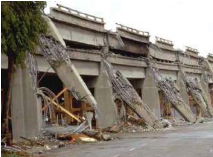
Figura 2.7. Colapso del Cypress Viaduct por falla de deslizamiento por corte en columnas (Calvi et al., 2007).
