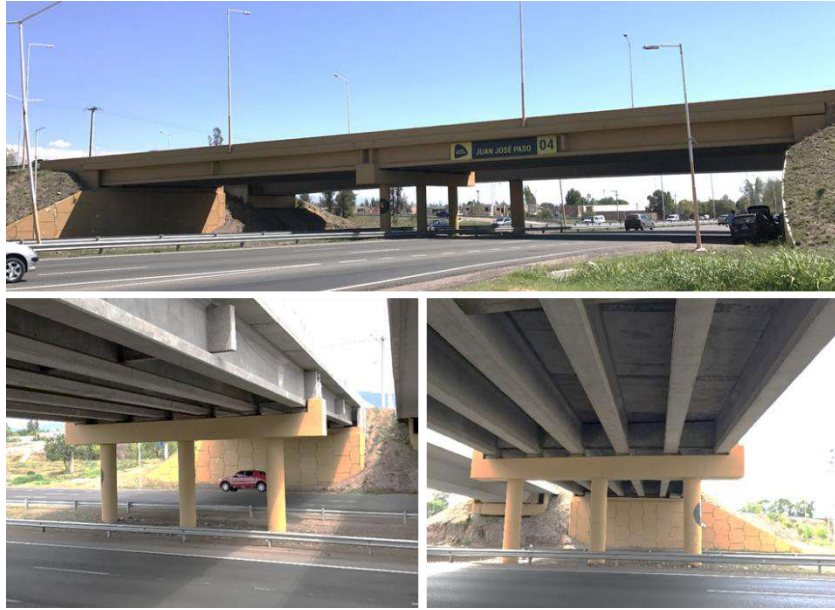
Figura 3.1. Puente de calle Paso, Intersección RP10 y RN40, provincia de Mendoza.
