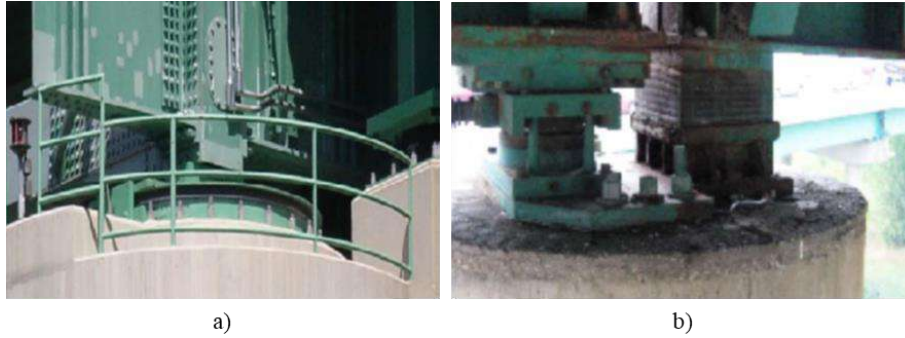
Figura.2.39. a) Péndulo de fricción instalado en el puente Hernando DeSoto en Tennessee. b) Combinación de un aislador de fricción con un apoyo de goma con núcleo de plomo en Illinois (Wright et al., 2011).
