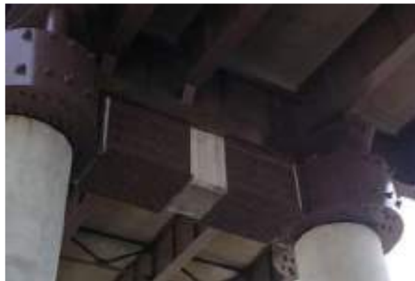
Figura 2.31. Encamisado metálico en una viga de Missouri (Wright et al., 2011)
