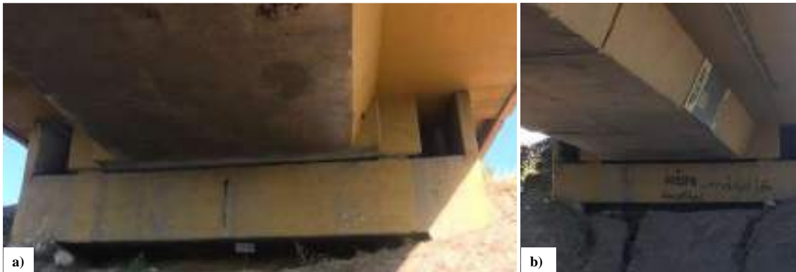
Figura 5.42. Apoyo de la superestructura en el estribo del puente de calle Boedo.
