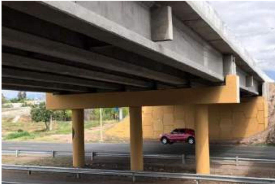
Figura 5.25. Puente de calle Paso.
