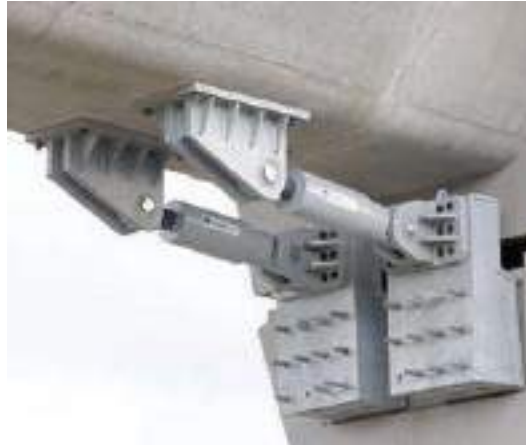
Figura.2.35. Amortiguador de fluido viscoso conectando la superestructura con las columnas del puente de aproximación al “Nanjing third Yangtze River bridge” (Yongqi et al., 2008).
