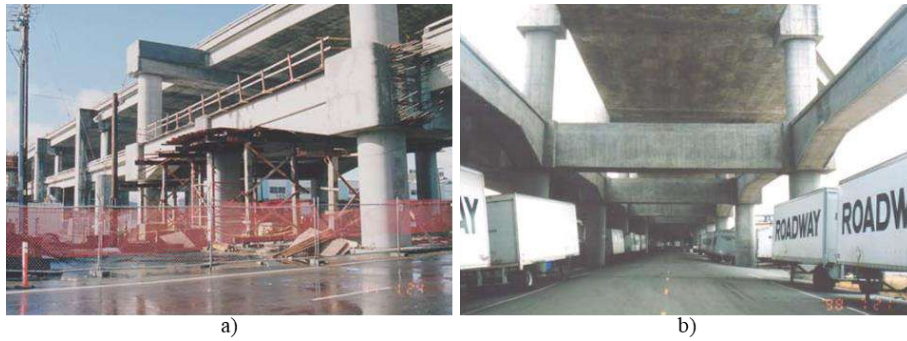
Figura 2. 30. a) Construcción de vigas de vinculación. b) Vista de las vigas de vinculación del viaducto doble de San Francisco (G. M. Calvi et al., 2007).
