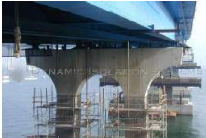
Figura 2.37. Instalación de aisladores de goma con núcleo de plomo en el puente Coronado en California ejecutado por DIS Inc.
