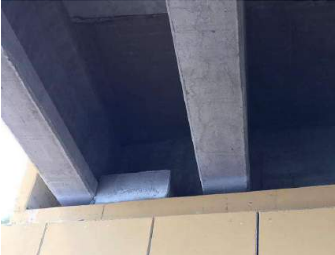
Figura 5.30. Fotografía de unos de los estribos del puente de calle Paso.
