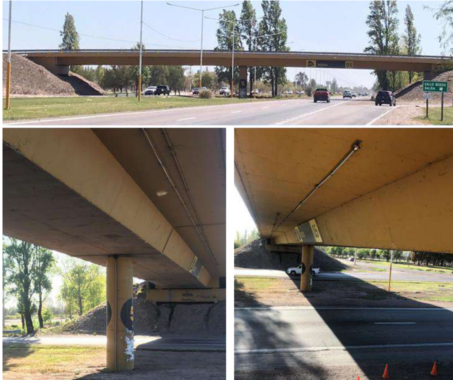
Figura 3.4. Puente de calle Boedo y RN40, provincia de Mendoza.
