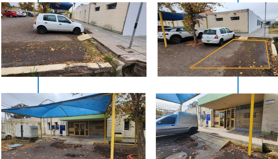
Rampas de acceso y estacionamiento para PcD – Comedor Universitario.
