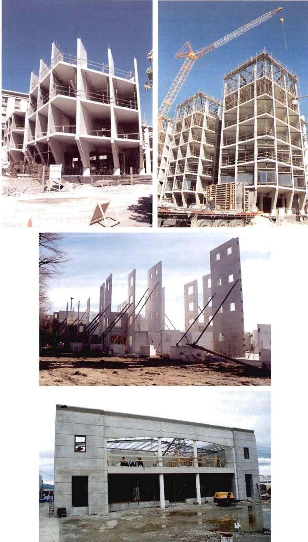
Figura 1 - Vistas de construcciones con paneles prefabricados
