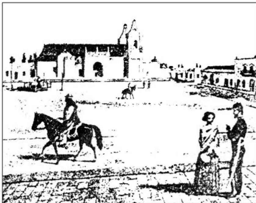
Vista de la Catedral de Mendoza en 1858. En primer plano la vereda norte de la plaza principal. (H. Burmeister, 1943, I: fig. 19)
