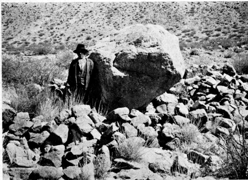
Detalle interior de la tapera representada en la fotografía precedente. Adviértase la utilización de un gran bloque de piedra para apoyo del muro (Fot. N° 7)
