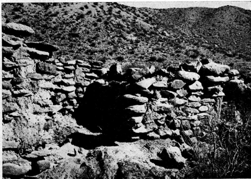
Detalle de una de las puertas interiores del gran recinto de pirca tomada con barro, edificado sobre el cono de deyección (Fot. N° 15)
