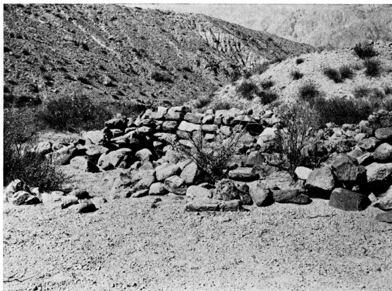
Detalle del estado de conservación de los "cimientos de taperas" (Fot. N° 4)
