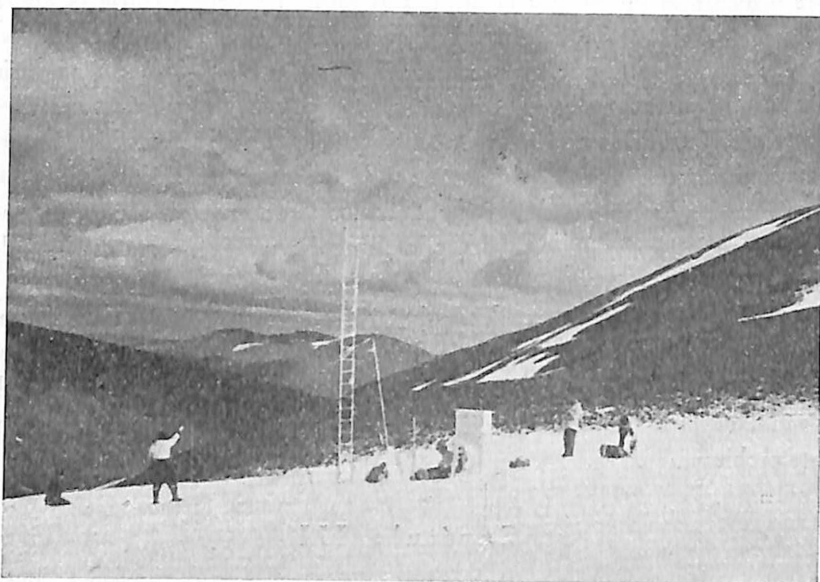
FIG. 4 - Construcción de la estación para medir temperaturas y vientos en diferentes alturas. (Fot. A. E. Corte - 20 - VII - 49).
